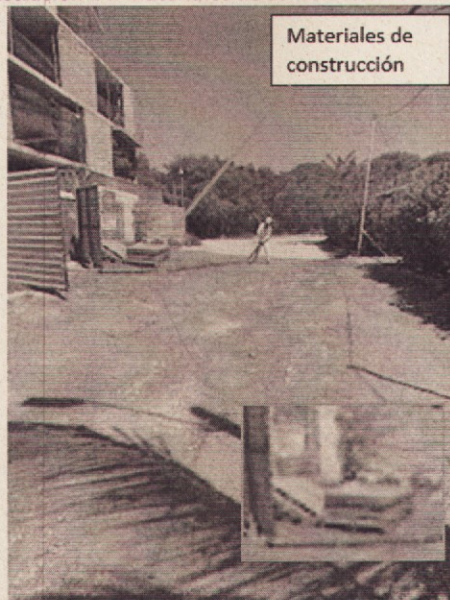
Ilustración 15. Materiales de construcción cubierto.
