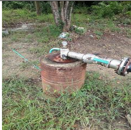
Foto 1. Tuberías del pozo
