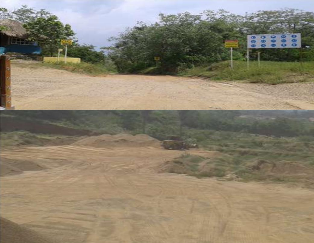
*Se observa acopios de material de explotación a lo largo de las zonas explotadas, apiques para determinar la continuidad en profundidad del yacimiento, no se evidenció volquetas para transporte de material de los frentes de trabajo hasta la planta de beneficio, como tampoco desde la planta de beneficio a centros de consumo.*
